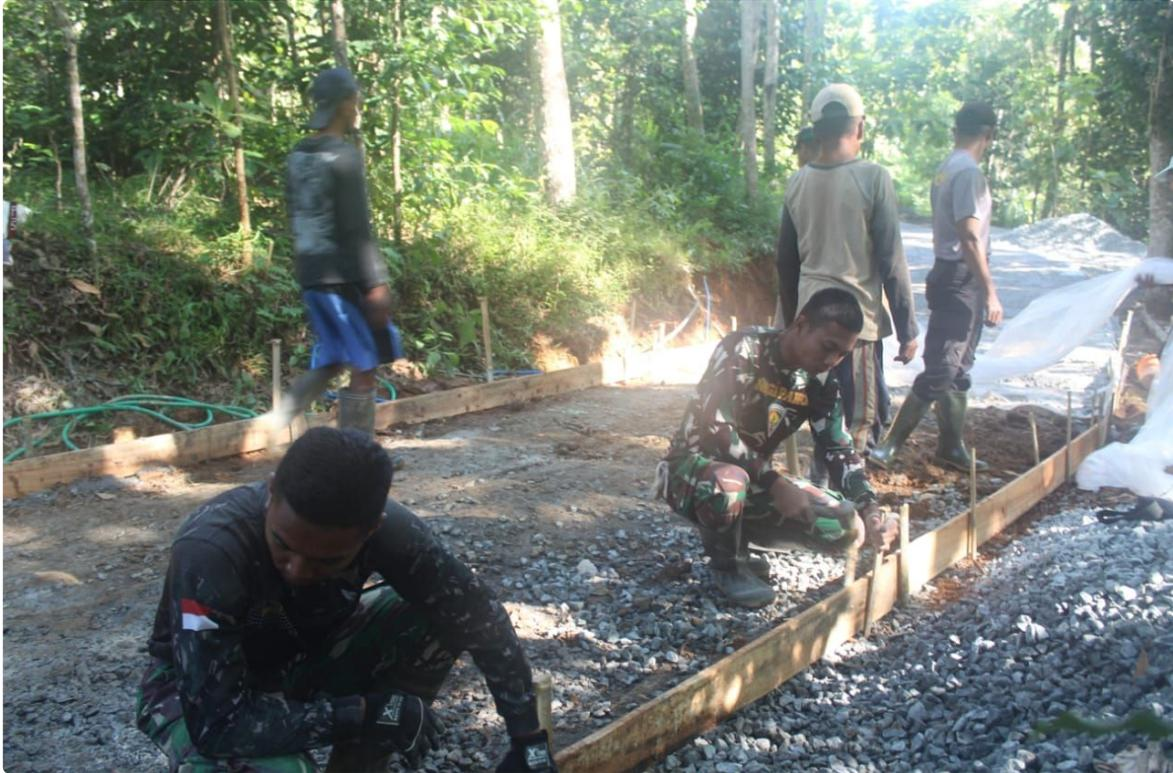
Seperti yang dilakukan Serda Tri anggota TMMD ke-116 Kodim Kebumen. Dia dengan penuh kesungguhan membantu Martoyo ,warga Pejengkolan, memasang papan pembatas pengecoran jalan.
